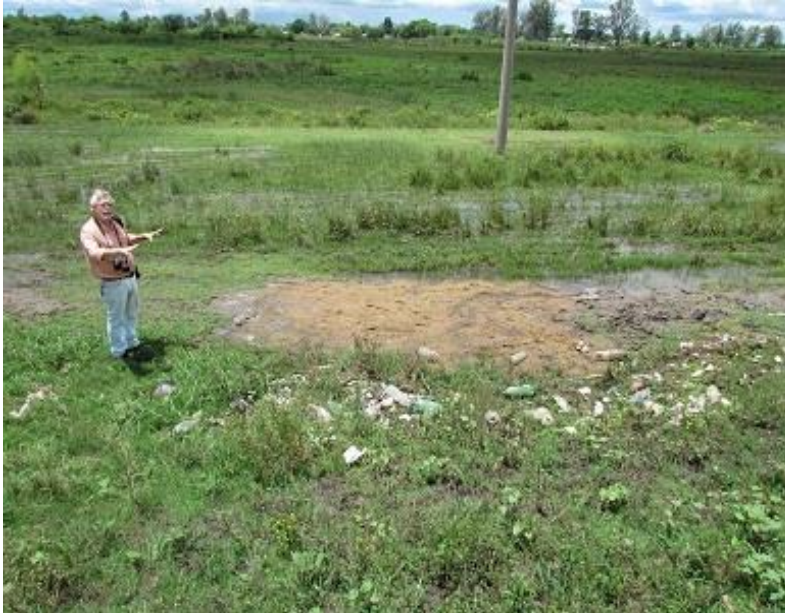
Gráfico 24 Filtraciones en la ladera seca. Defensa de Concordia. Entre Ríos
