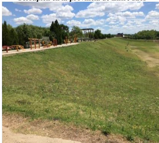
Gráfico 14 Terraplén en la provincia de Entre Ríos
