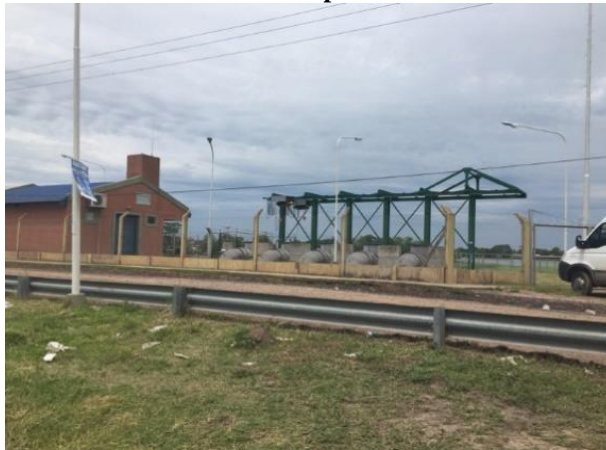
Gráfico 15 Estación de bombeo en la provincia de Corrientes
