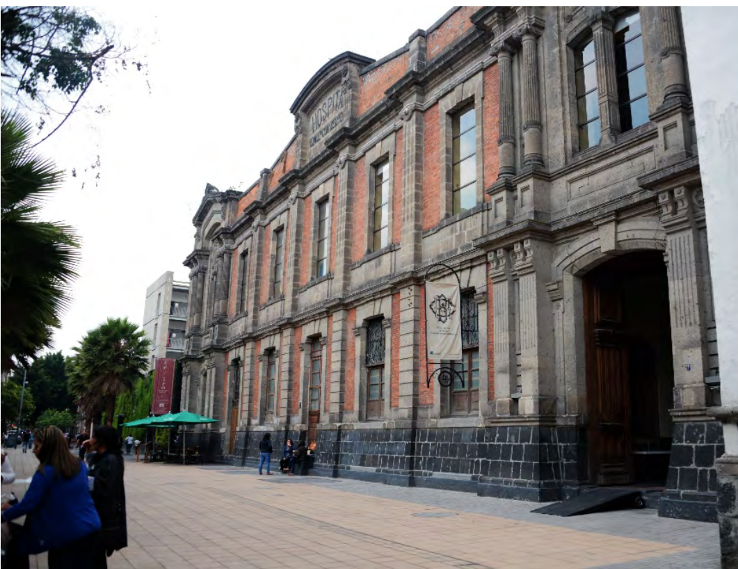
Edificio de la Fundación para Ancianos C. Béistegui
