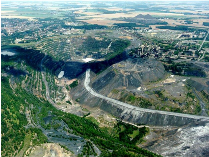
Figura 1. Tajo abierto residual de Lichtenberg, en el sitio de Ronneburg (1992)
