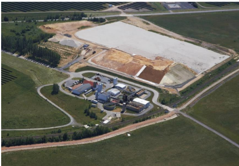
Figura 3. WTP de Ronneburg y sitio de disposición para los residuos tratados
