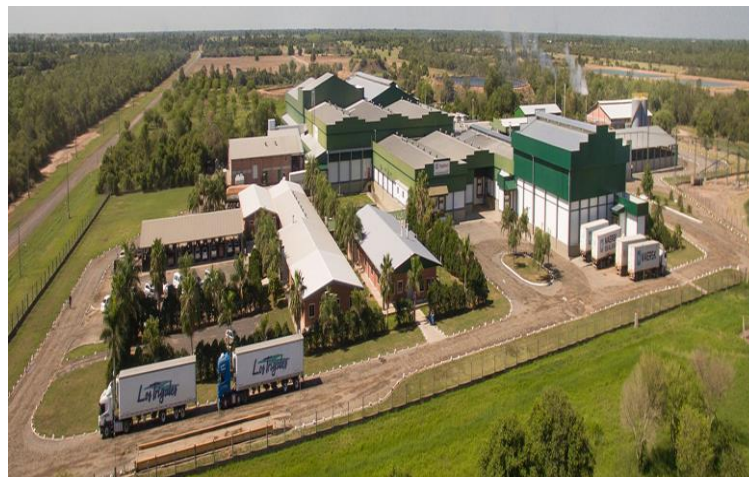
Complejo frigorífico actual
