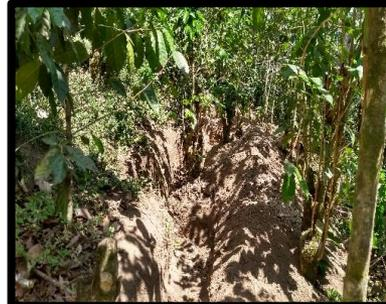
Zanjas de infiltración
