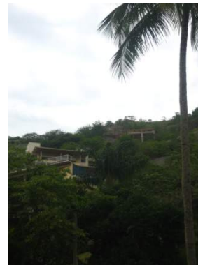
Área de risco de queda de blocos - Sta Tereza/Ilhabela (Levantamento em campo, 22/11/2011)
