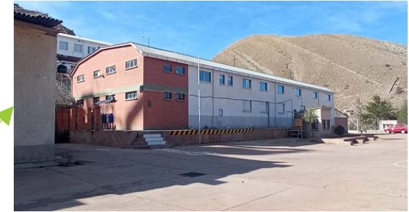
Planta Piloto de Baterías (2014)
