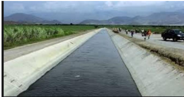
Canal de riego
