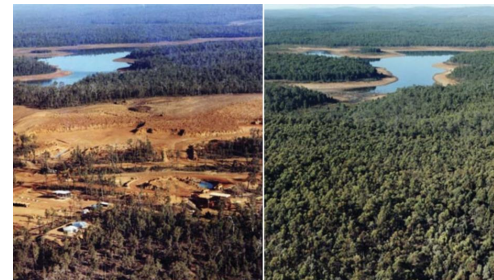
Erosión de minas rehabilitadas
