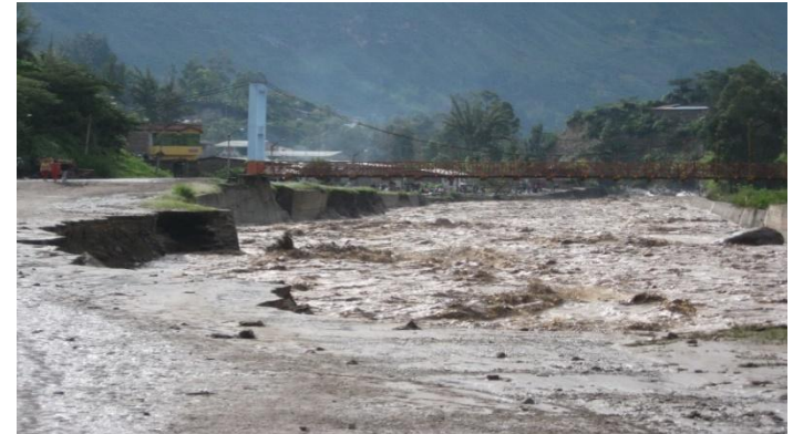
Huancabamba - Piura - Perú desborde e inundación
