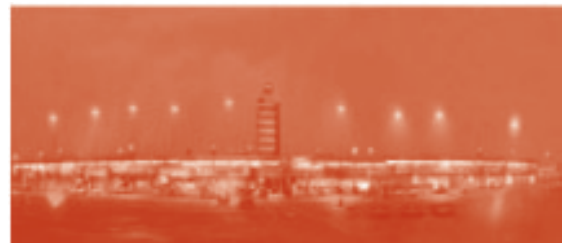
LIMA AIRPORT PARTNERS Aeropuerto Internacional Jorge Chávez
